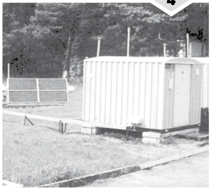
Безлюдный комплекс «Резерв» в «солнечной» комплектации.
