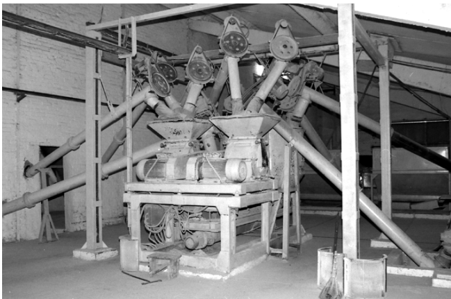
Автоматизированный агрегат приготовления обогащающих и лекарственных микродобавок АП-100 производительностью до 100 кг/ч.
