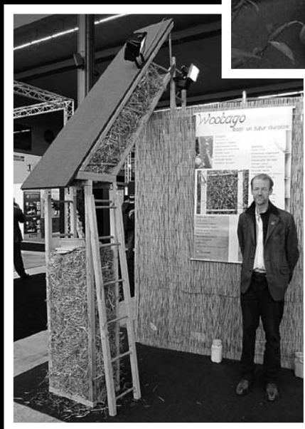
Элемент утеплителя, заполненный соломой.
